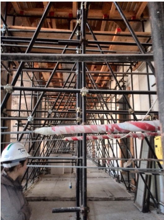
Particolare della messa in sicurezza al primo piano
