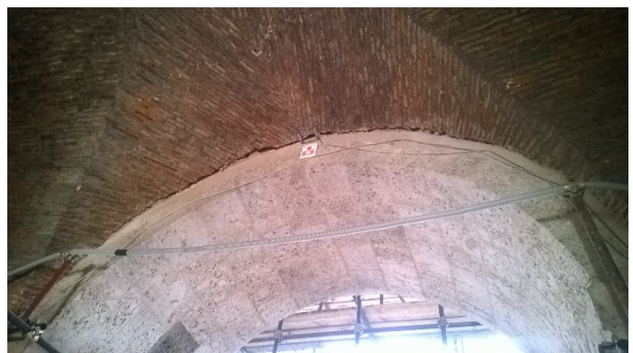
Particolare del distacco della parete del porticato
